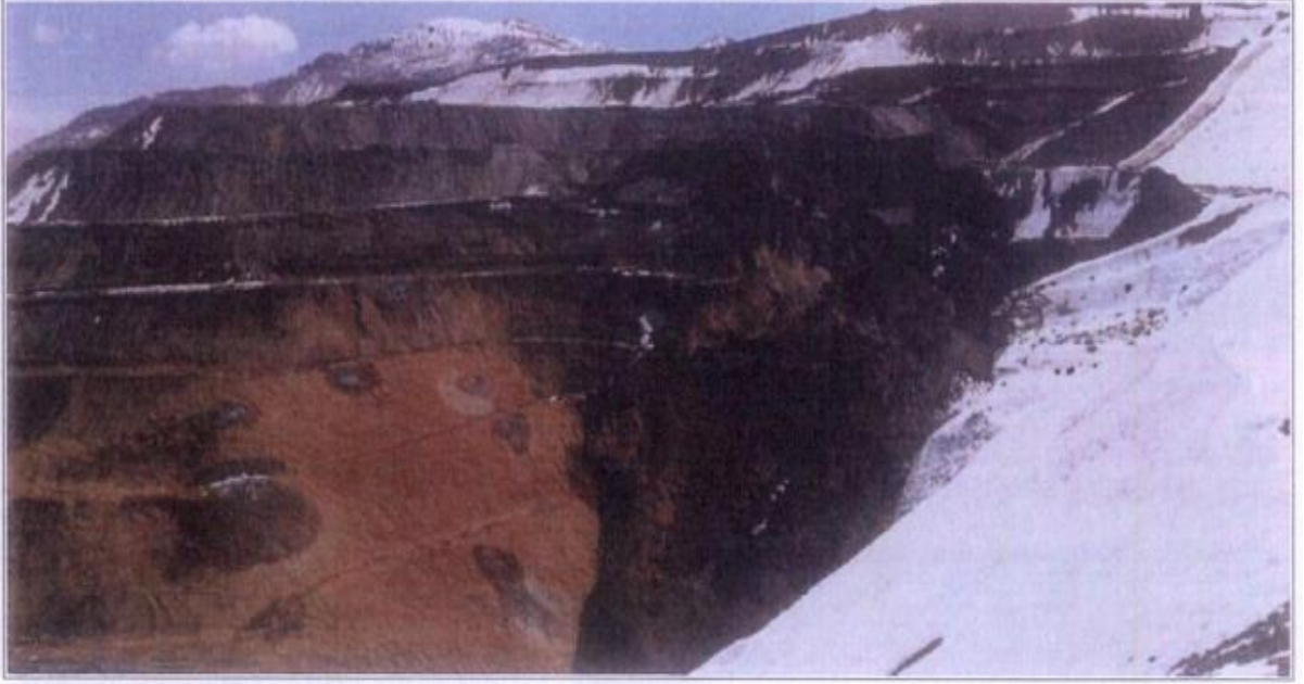
Fotoğraf 3 Yığın Liçi Sahası Faz-4B Aşama-1 Yenilme Bölgesi (28.03.2022)
